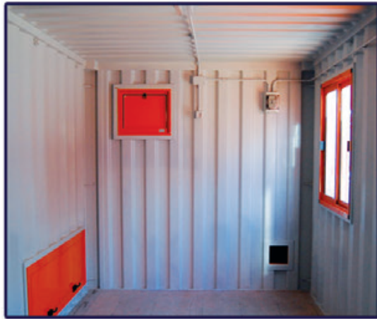
Impianto elettrico e infissi
