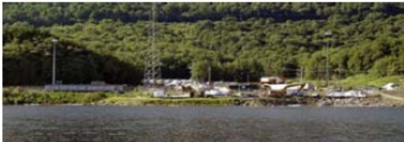
Centrale di Yankee Rowe
