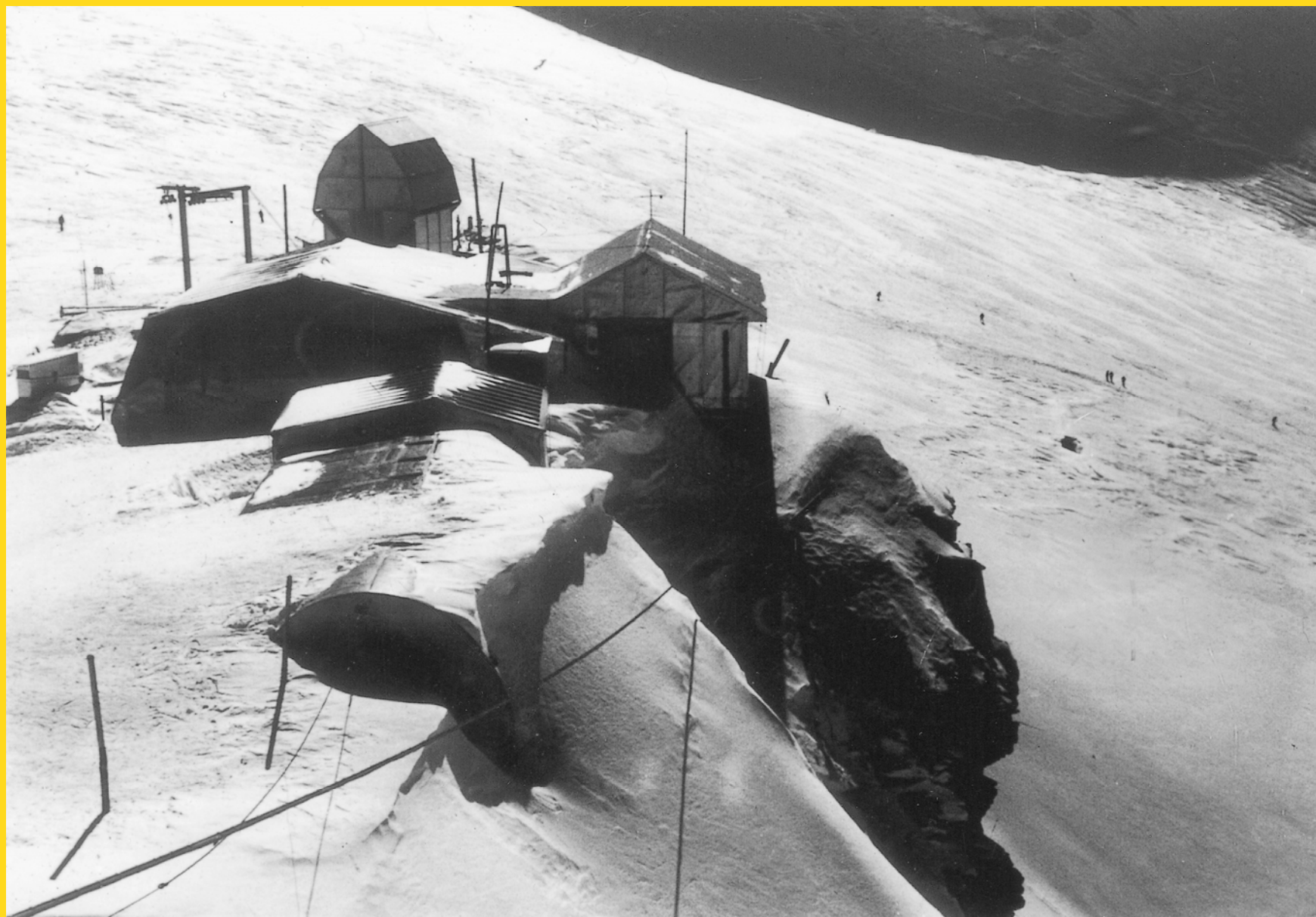
Il laboratorio della Testa Grigia per lo studio dei raggi cosmici, realizzato nel 1947 presso la stazione superiore della funivia del Plateau Rosa sopra Cervinia, a 3500 metri di quota.
