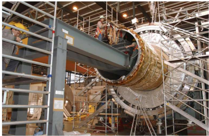
Magnete solenoidale centrale
