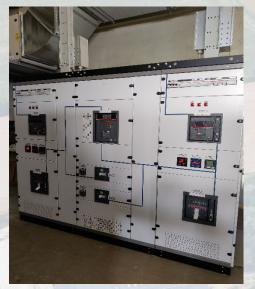
Completamento Installazione Nuovo Quadro di Alimentazione per il nuovo CED dei LNL in fase di realizzazione
