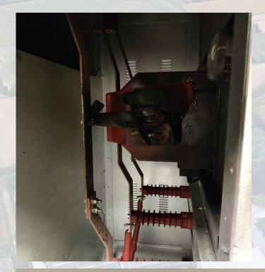
Esplosione TV su cella Misure cabina Media SF6 del 28/03/2024 – disalimentazione di tutto il Laboratorio
