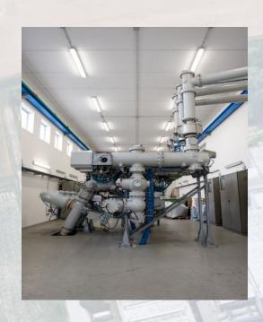
Stazione in esecuzione blindata in alta tensione 132/20 KV della potenza di 32000/40000 KVA
