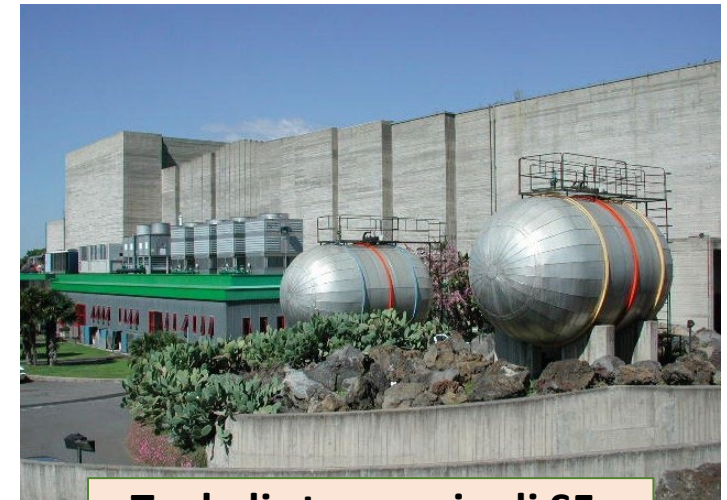
Tank di stoccaggio di SF 6
