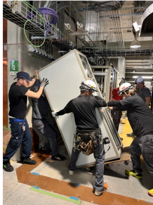
Trasporto e posizionamento di buffer e rack, nella mixing room e nel pit
