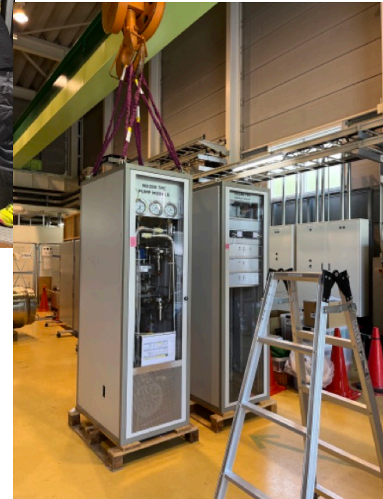
Trasporto e posizionamento di buffer e rack, nella mixing room e nel pit
