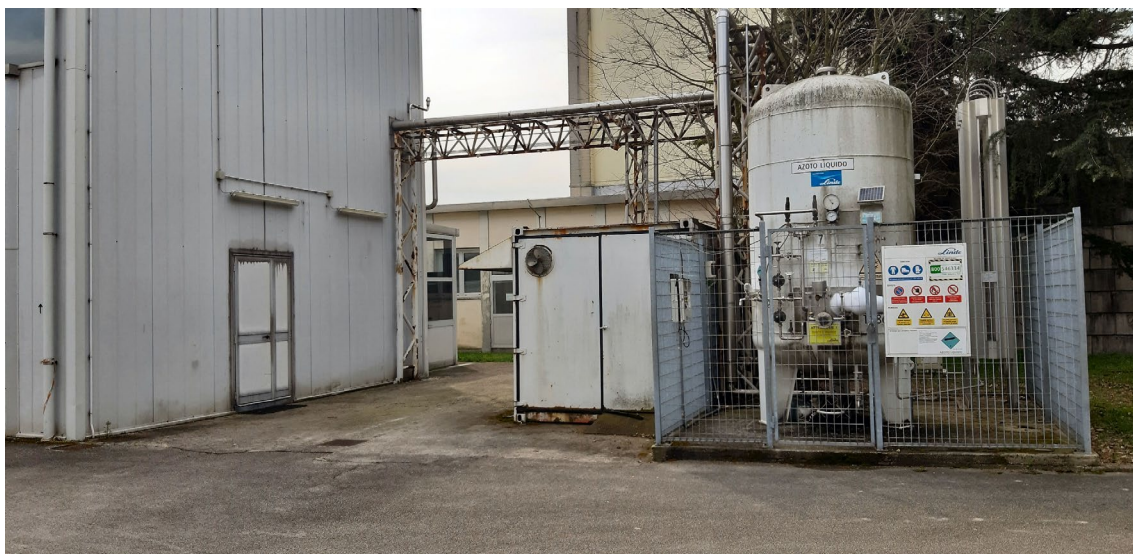
Figure 8b: Le linee criogeniche di distribuzione, già connesse al dewar di 5000 litri esterno
