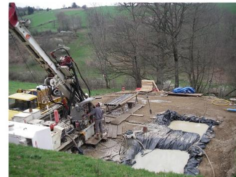
Sondage A89 (2007) incliné de 45° de 125 m (surface plateforme estimée : 12 x 12 m soit environ 150 m²)
