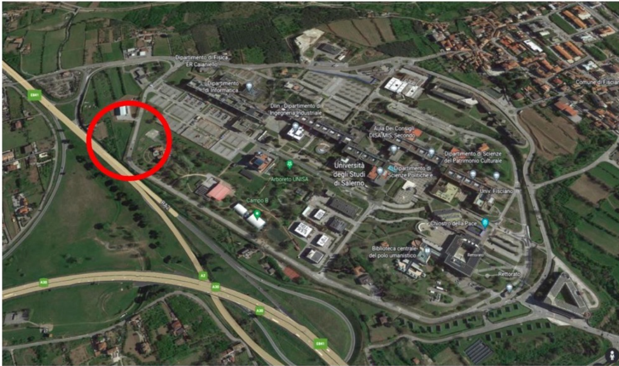
Figura 1 – Vista aerea del Campus ed individuazione del lotto su cui sarà realizzato l'edificio
