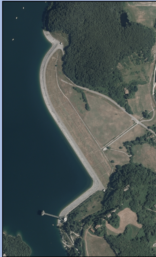
Diga di Bilancino (FI)
