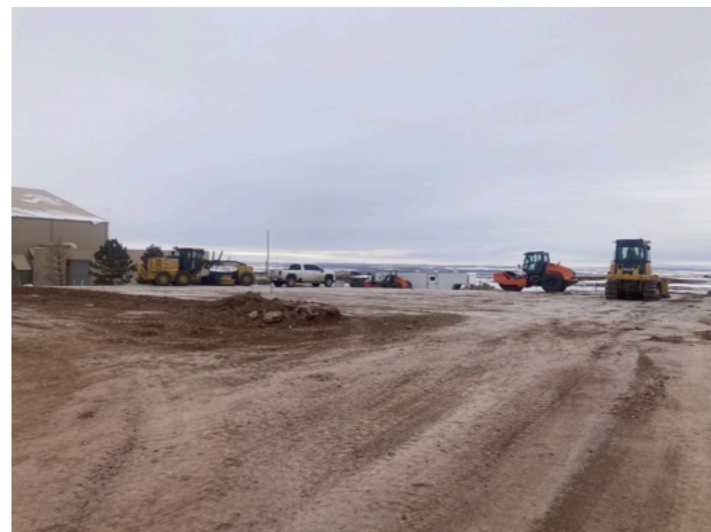
Urania Site Construction
