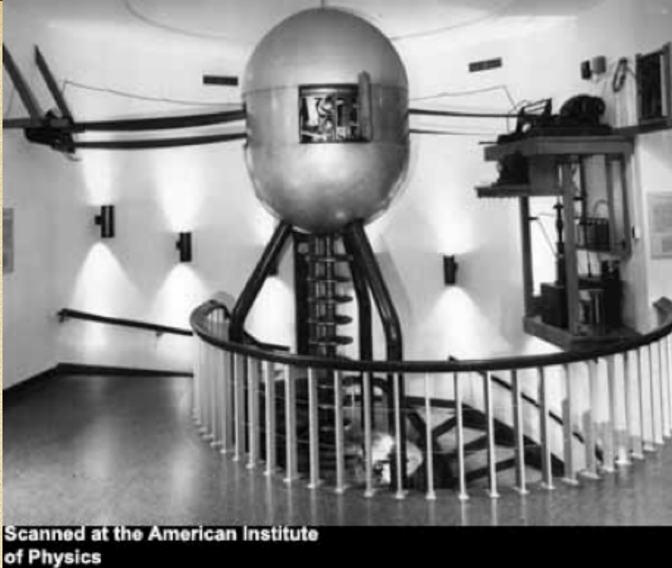
Un acceleratore van de Graaf da 1 MeV (1931)
