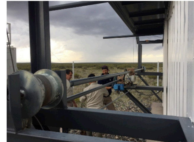
Sostituzione motoriduttore lato dx
