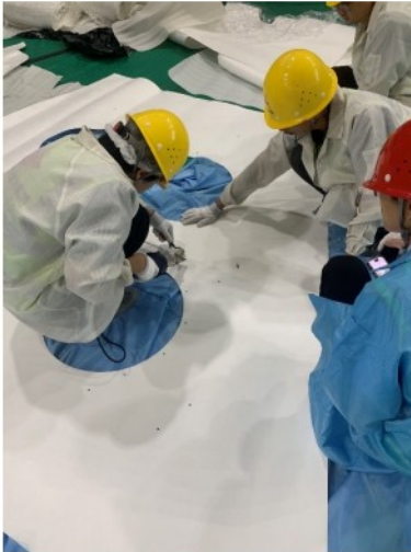
Tyvek layer installation
