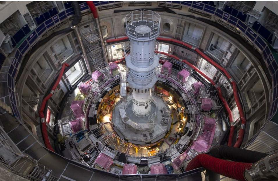
L'interno del criostato con la bobina poloidale n.6 e dummy solenoide centrale
