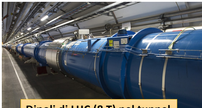
Dipoli di LHC (8 T) nel tunnel
