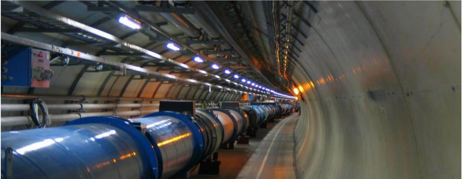
**1232 magneti super-conduttori (1.9 K, -271°C) mantengono i protoni di 7 TeV sull'orbita circolare di 27 km.**
