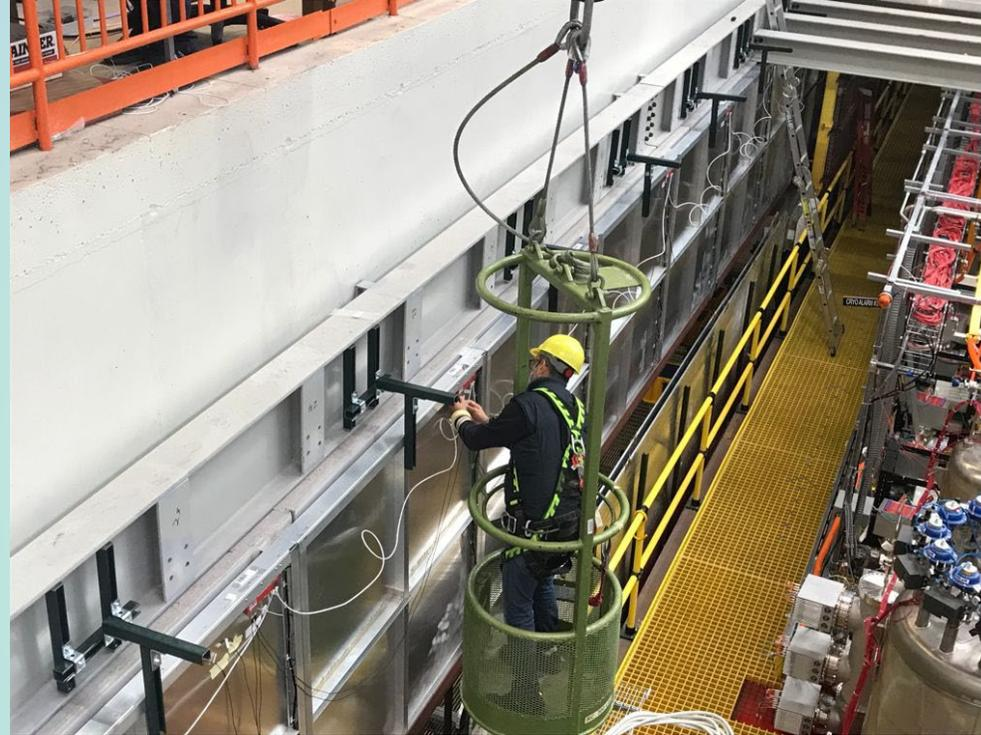
**Cablaggio dei Cosmic Ray Tagger (CRT)-top di Icarus a FNAL**
