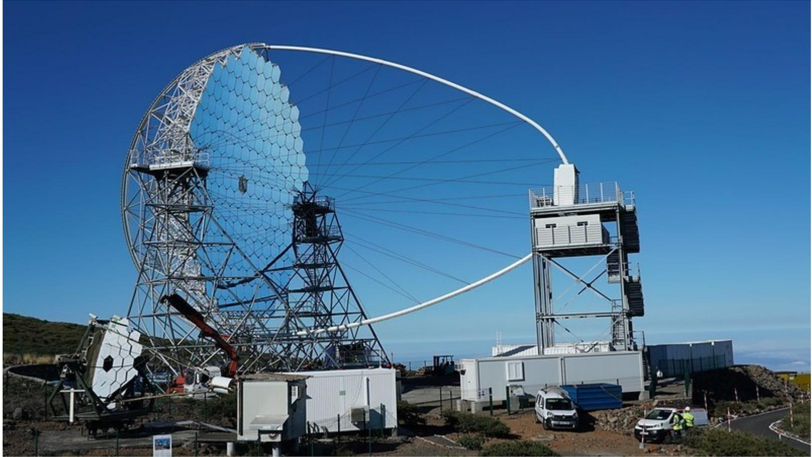
23m di diametro, 100ton, rivela raggi gamma da 20GeV e può ruotare in 30sec
