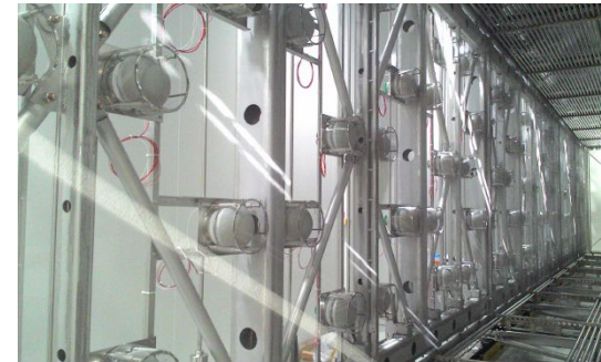
360 nuovi PMT installati nelle 4 TPC di ICARUS, attualmente utilizzati a Fermilab
