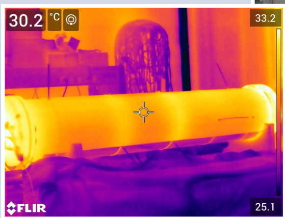
Immagine termica da termocamera
