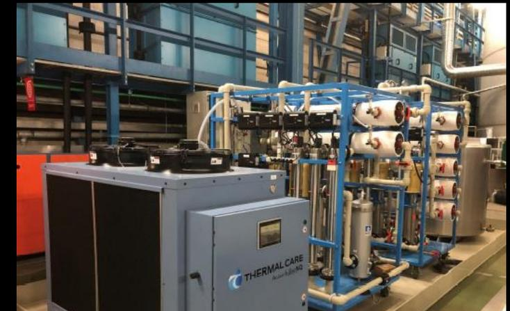
Impianto di purificazione Gd+Acqua, attualmente in fase di test ai LNGS
