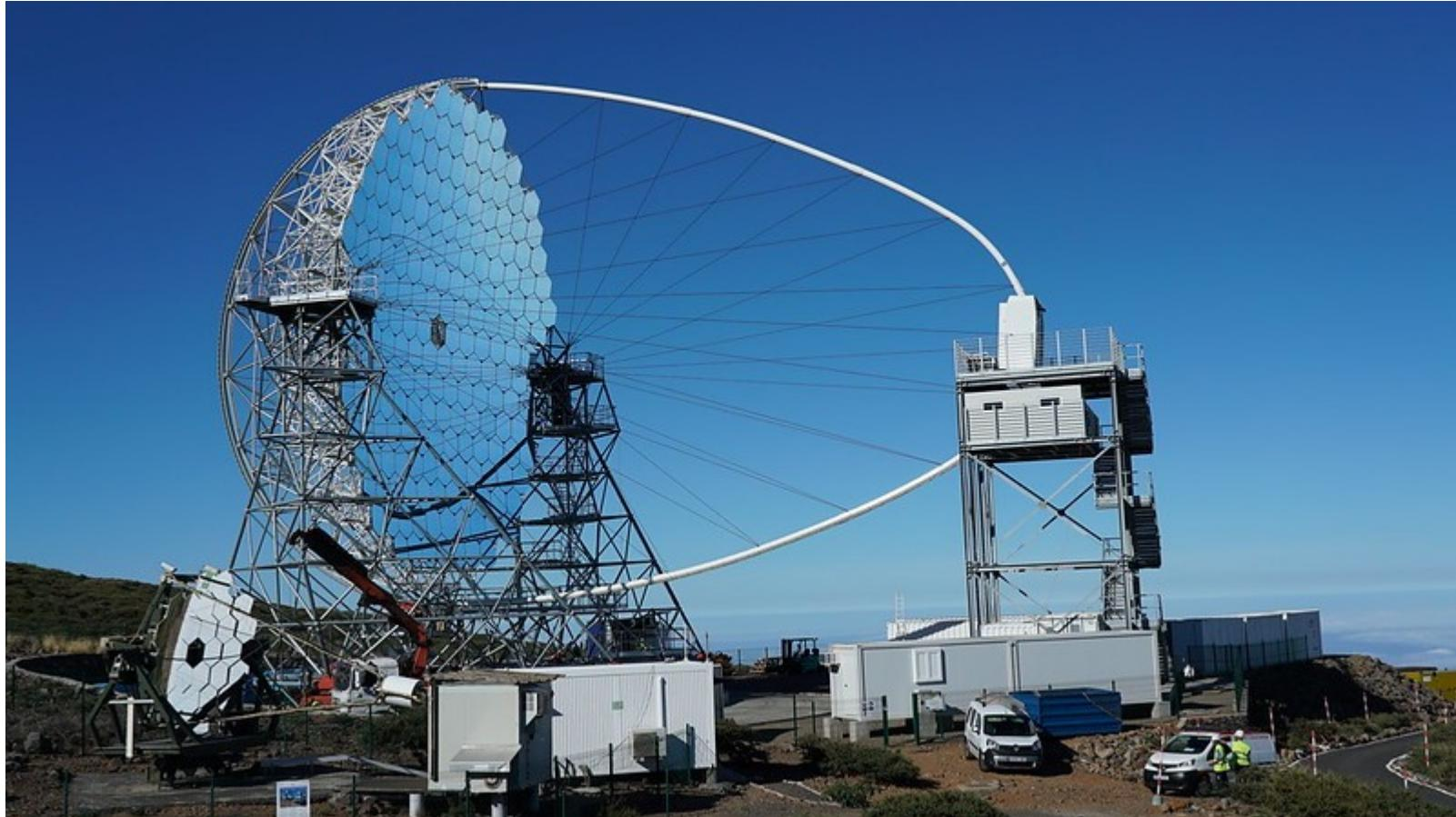
23m di diametro, 100ton, rivela raggi gamma da 20GeV e può ruotare in 30sec
