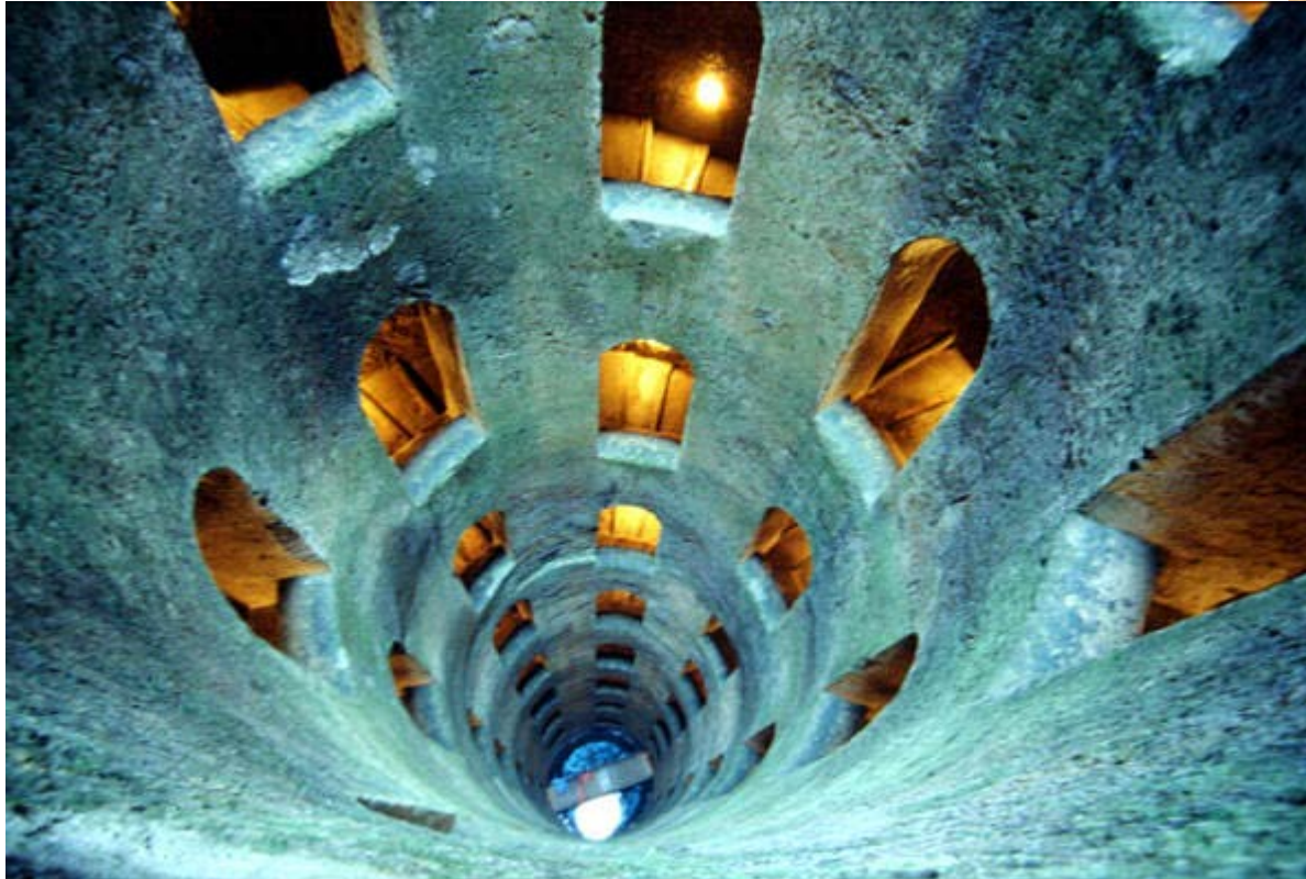
Pozzo di S. Patrizio - 1527 - 1537
