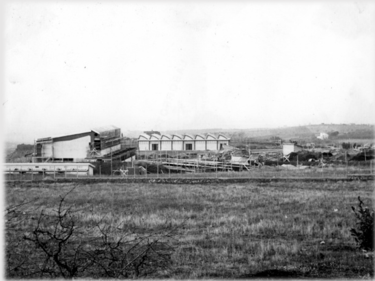
Complesso di Frascati in costruzione
