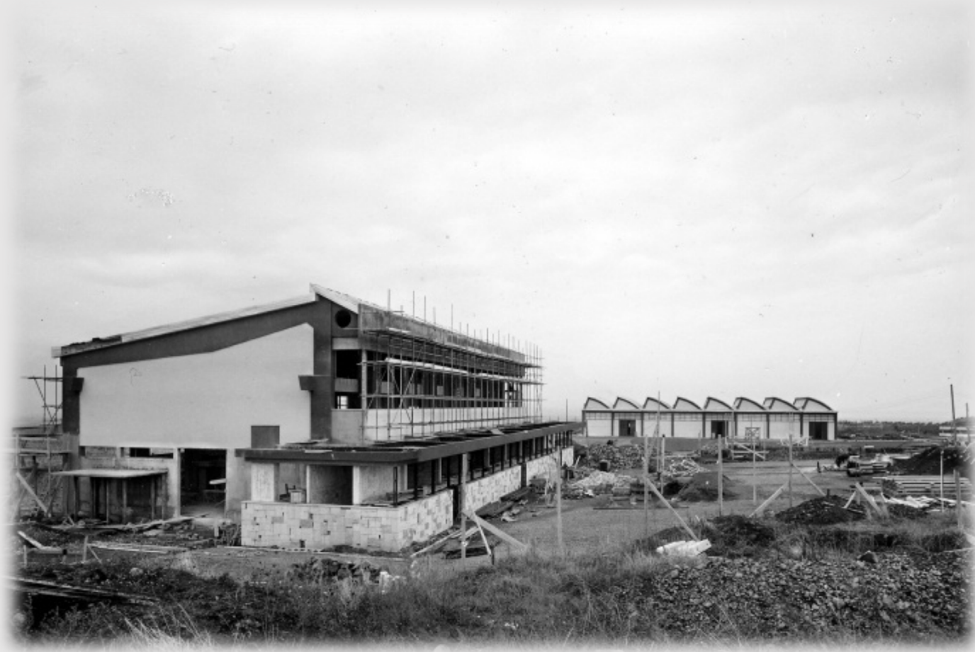
Complesso di Frascati in costruzione
