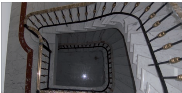
Villa Orion - Villefranche sur Mer - France Steel and brass railings - Garde-corps acier et laiton
