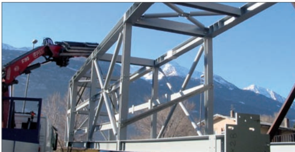
Park Azur - Aéroport de Nice Côte d'Azur - France Elevator structure - Structure ascenseur
