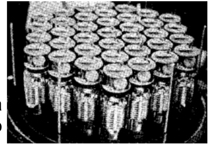
Anger camera: matrice di fototubi in una foto degli anni '60
